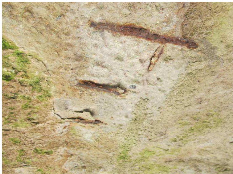
Koroze kari sítě torkretu na spodním líci nosné konstrukce.
