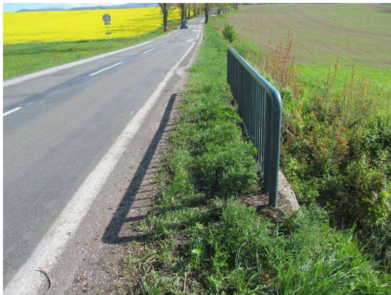
Vegetace uchycená podél pravé římsy.
