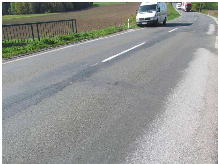
Příčná trhлина ve vozovce.
