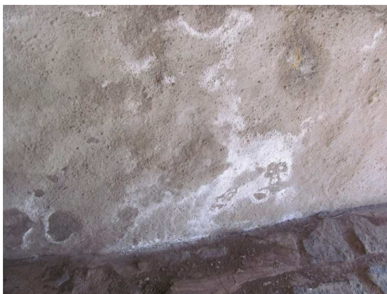
Stopy po průsacích na dřívku opěry OP2.
