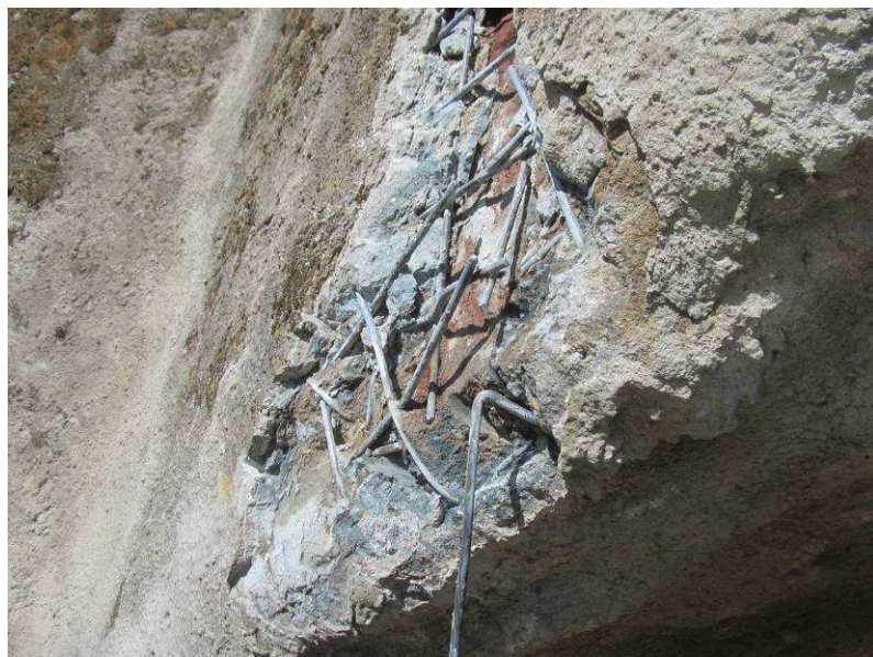
Sonda ke zdivu nosné konstrukce klenby.
