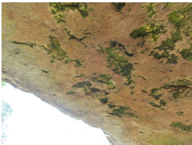
Stopy po zatékání, biocidní napadení a degradace torkretu na spodním líci nosné konstrukce.
