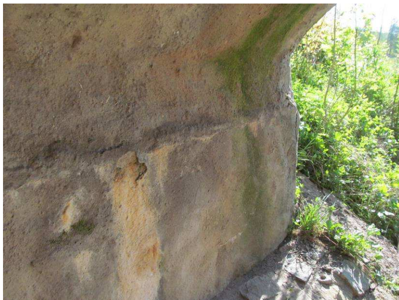
Stopy po zatékání, výluhy pojiva, lokálně odpadlý torkret na pravé straně opěry OP2.
